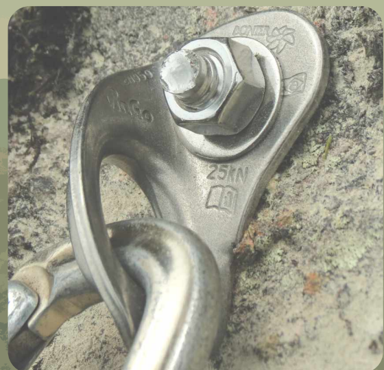
Chapeleta PinGo colocada na via Tá na Cara, 2025.
